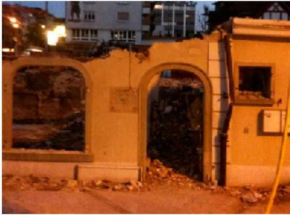
Ehem. Rest. Schmiede, Pilatusstr. 47, Luzern
